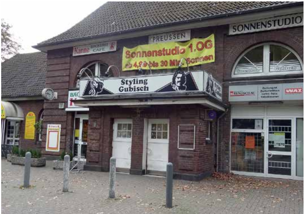
Außenansicht des Bahnhofs Preußen vor der Modernisierung
