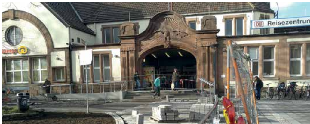
Modernisierung des Bahnhofs in Schwerte
